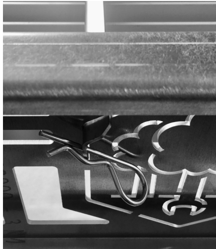
Abbildung 13: Sicherung der Strebe mit Sicherungssplint
